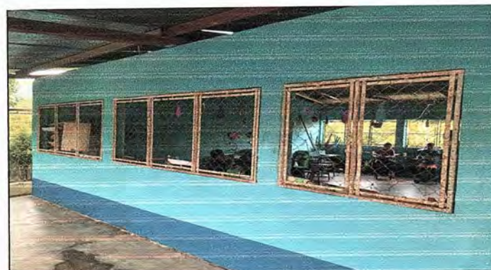
Foto 4: Se restaurarán los balcones de las dos aulas del módulo 2 ya que estos son de malla, se pintarán y se reforzarán con llantas. También se pintarán muros exteriores.
