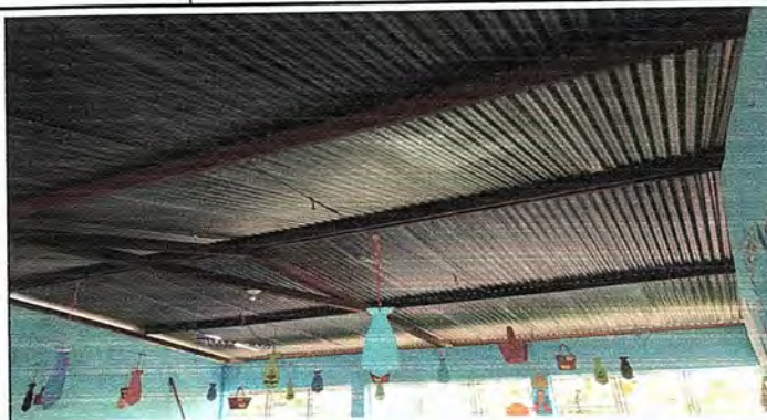
Foto 2: Aula 2 del módulo 2. Mantenimiento a estructura de techo y aplicación de anticorrosivo.
