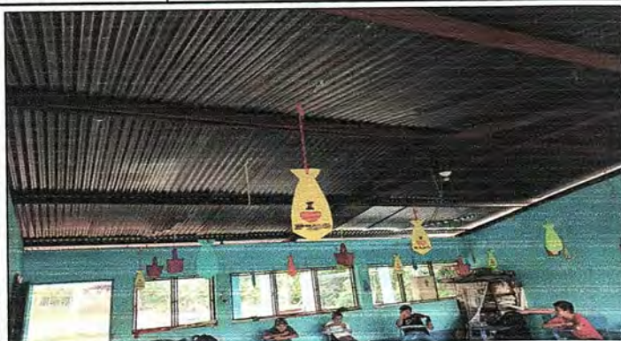
Foto 1: Se hará cambio de lámina por lámina troquelada, se pintará con anticorrosivo la estructura y se reforzará la misma con cuatro costaneras más. Aula 1 del módulo 2.
